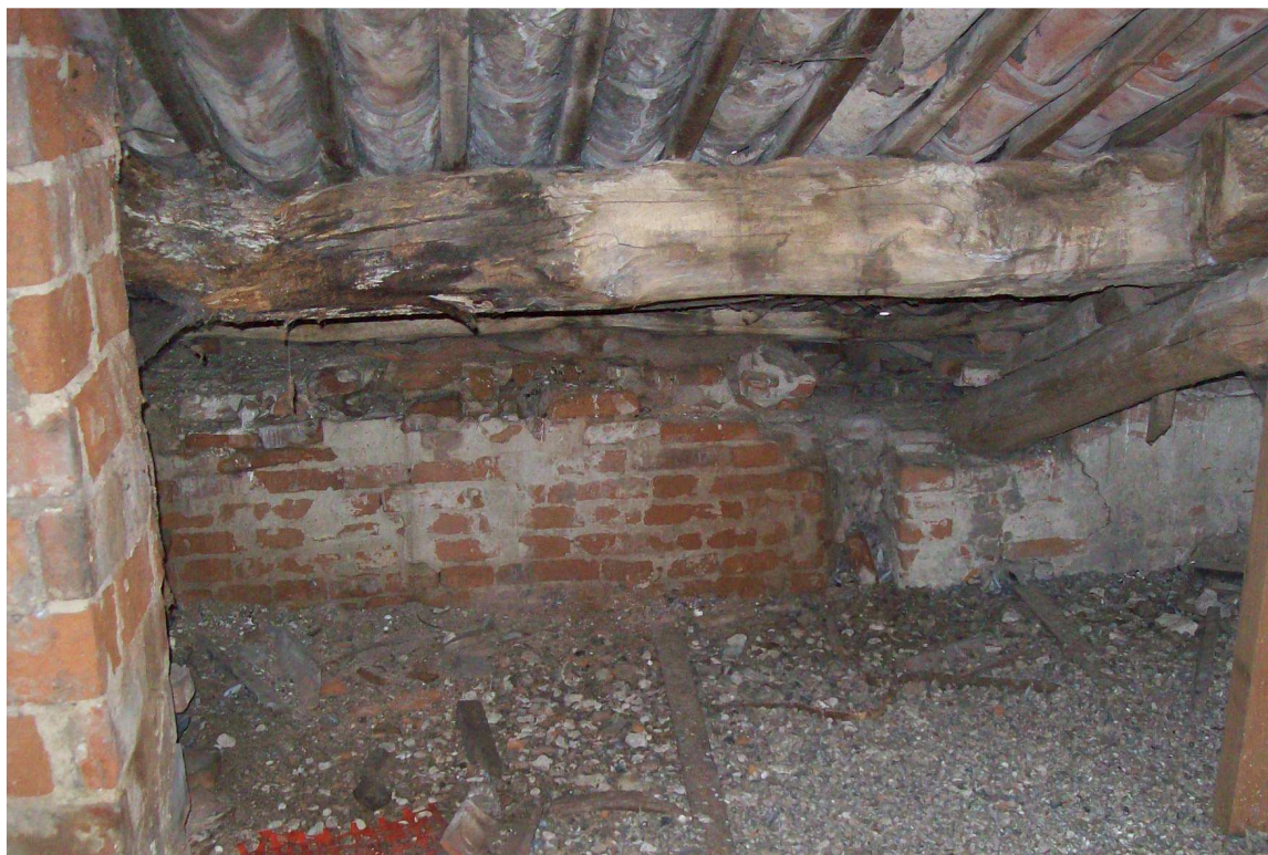
Figura n. 29 – Orditura ammalorata
