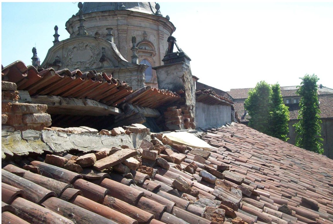
Figura n. 16 – Degrado della copertura
