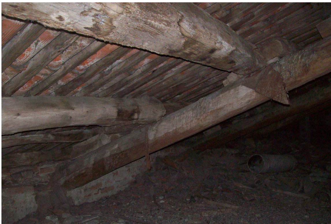
Figura n. 23 – Degrado dell'orditura primaria e secondaria
