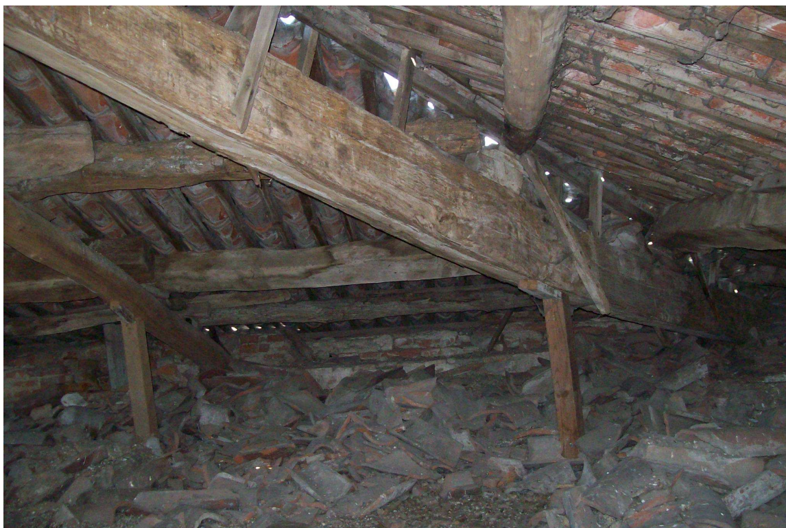
Figura n. 27 – Degrado e detriti nel sottotetto
