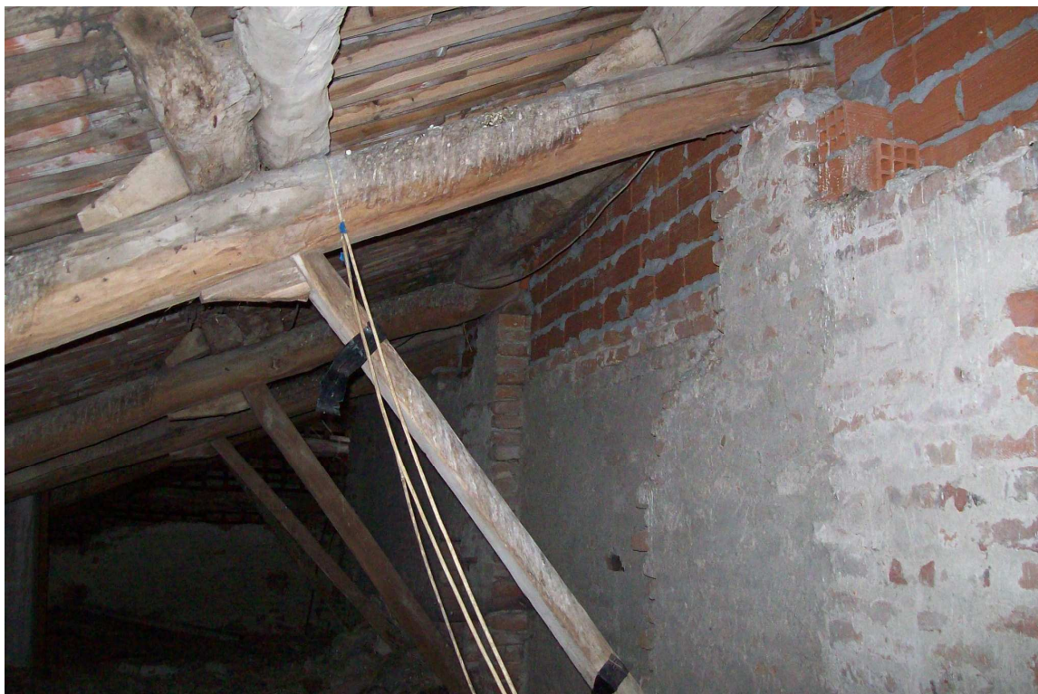
Figura n. 24 – Saette aggiuntive collegate ai falsi puntoni
