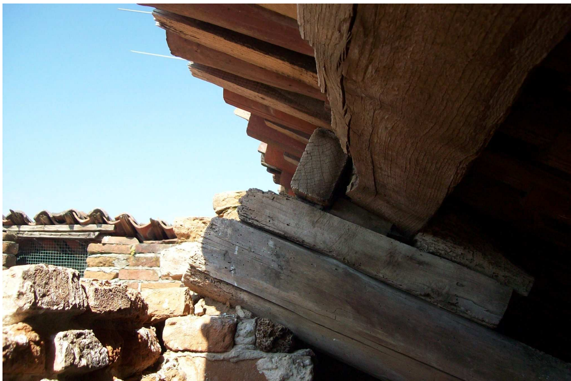
Figura n. 18 – Degrado orditura lignea
