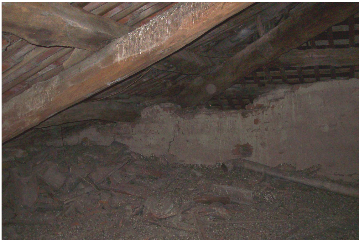
Figura n. 26 – Degrado e detriti nel sottotetto
