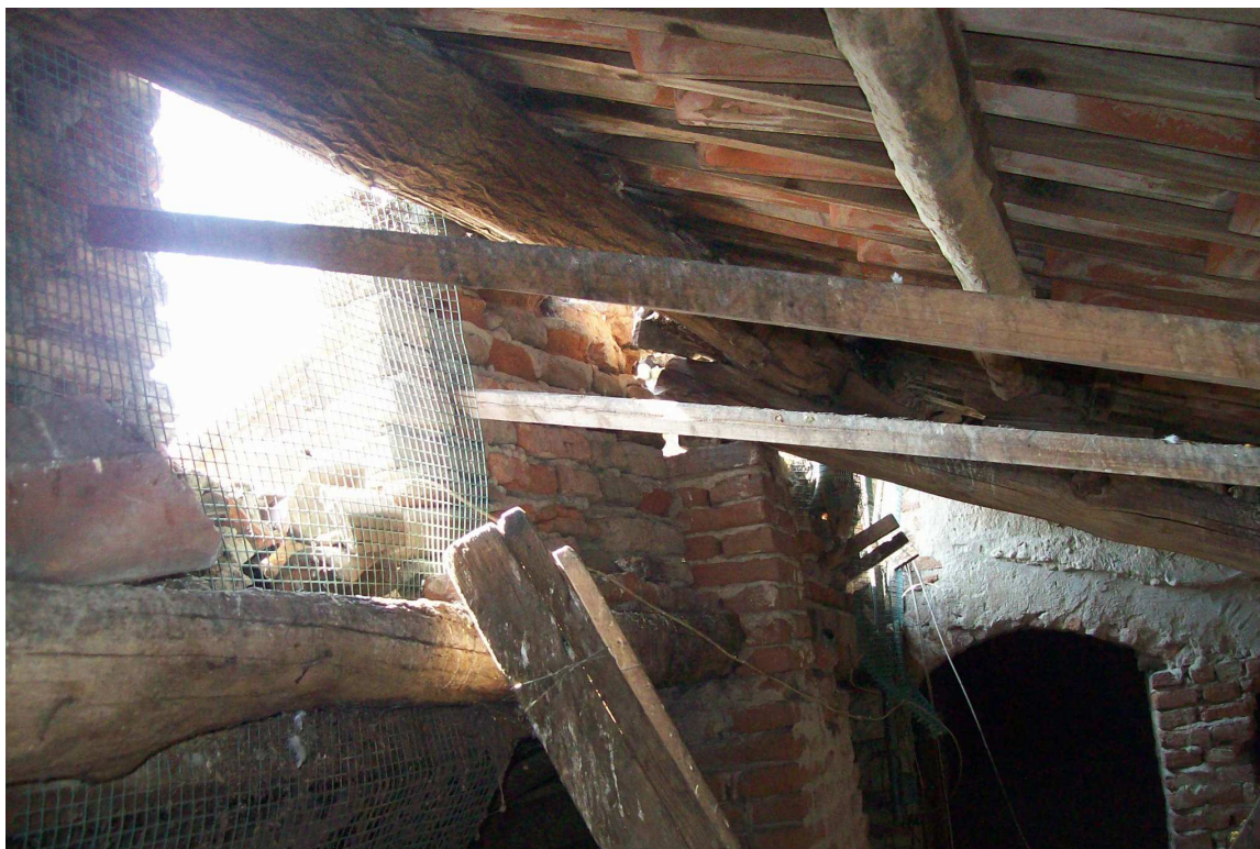
Figura n. 28 – Degrado del sottotetto: reti antivolatili divelte
