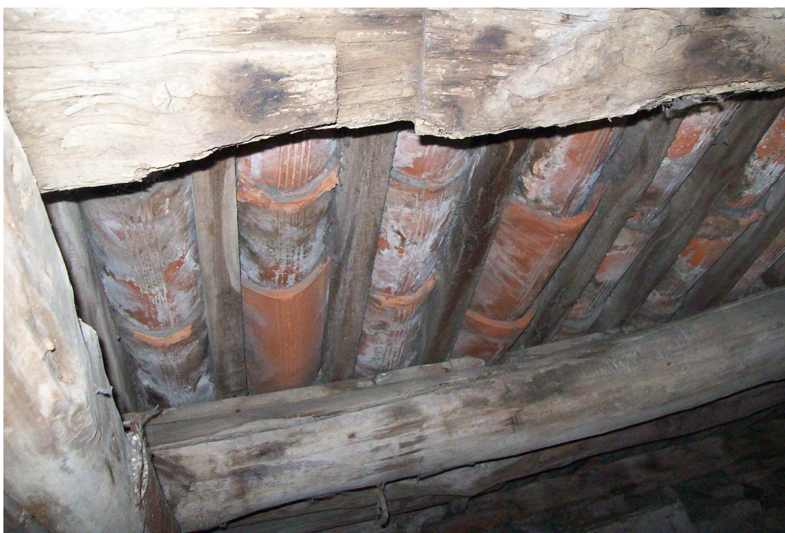
Figura n. 25 – Degrado del manto in coppi
